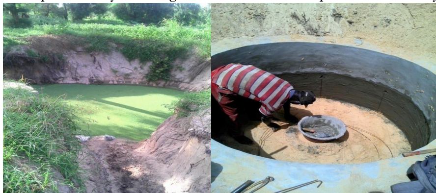
1. Céane creusée dans une exploitation 2. Réalisation de bassin de stockage de l'eau
