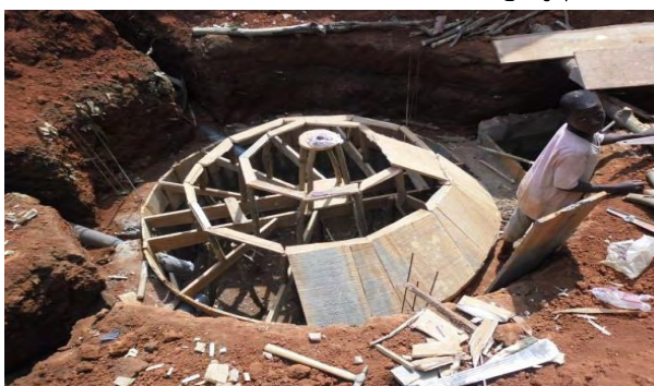
Photo 2b. La construction du dôme
