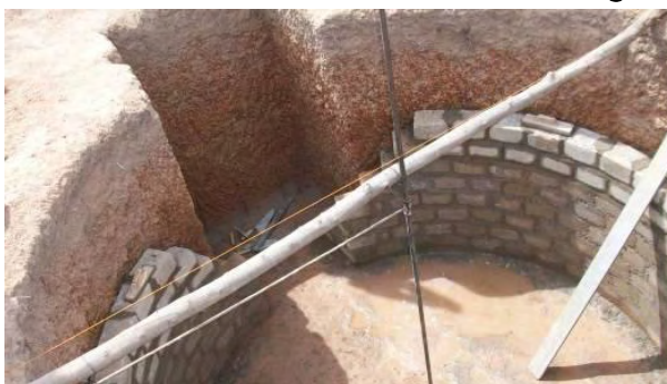
photo2a. Construction du détenteur du gaz (le dôme)
